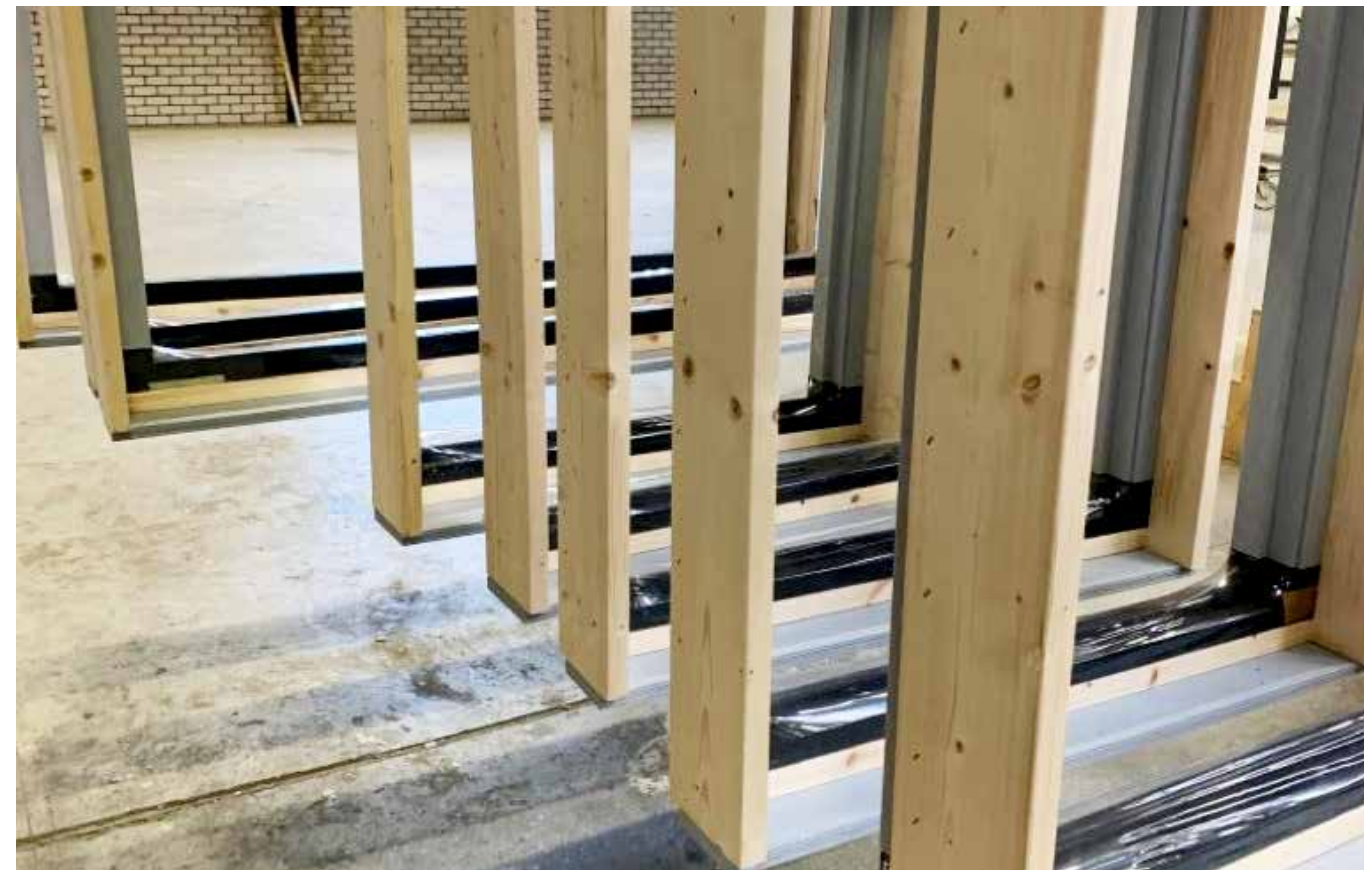
Kozijnen voorzien van dorpels voor de spuiseterij
